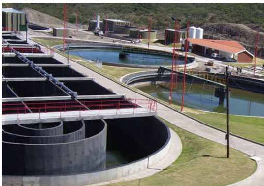
Fuente: Ente Nacional de Obras Hídricas de Saneamiento
