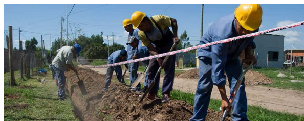
Fuente: Ente Nacional de Obras Hídricas de Saneamiento
